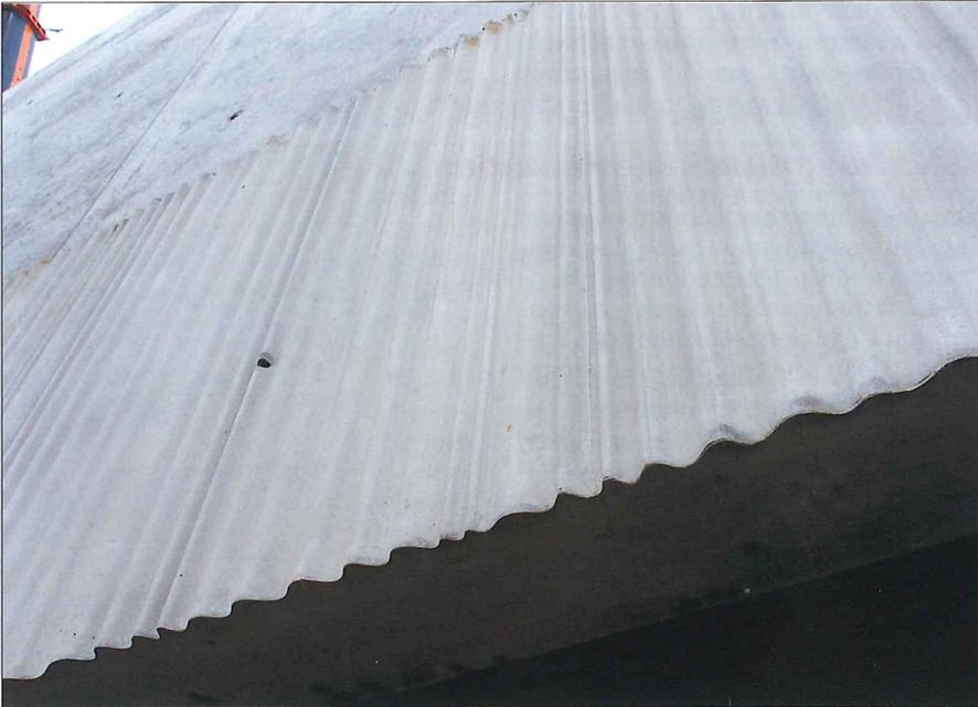
*Sichtbetonflächen mit Wellenmuster-Relief haben nicht nur eine ästhetische Wirkung, sondern dienen vor allem auch dem Schallschutz: An der strukturierten Oberfläche werden Schallwellen gebrochen.*
