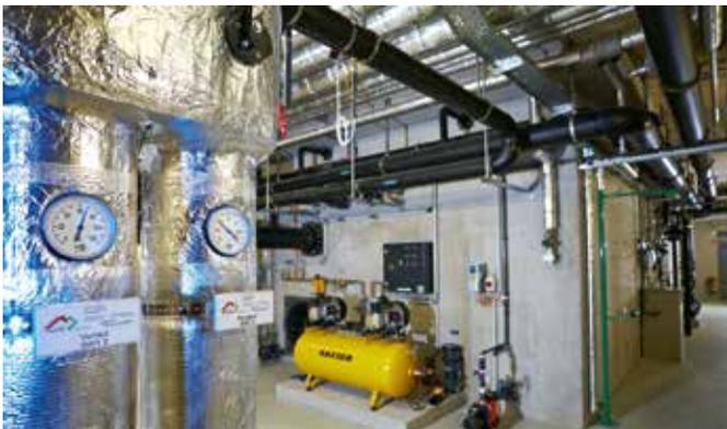
▲ Druckluftanlage für pneumatische Antriebe
