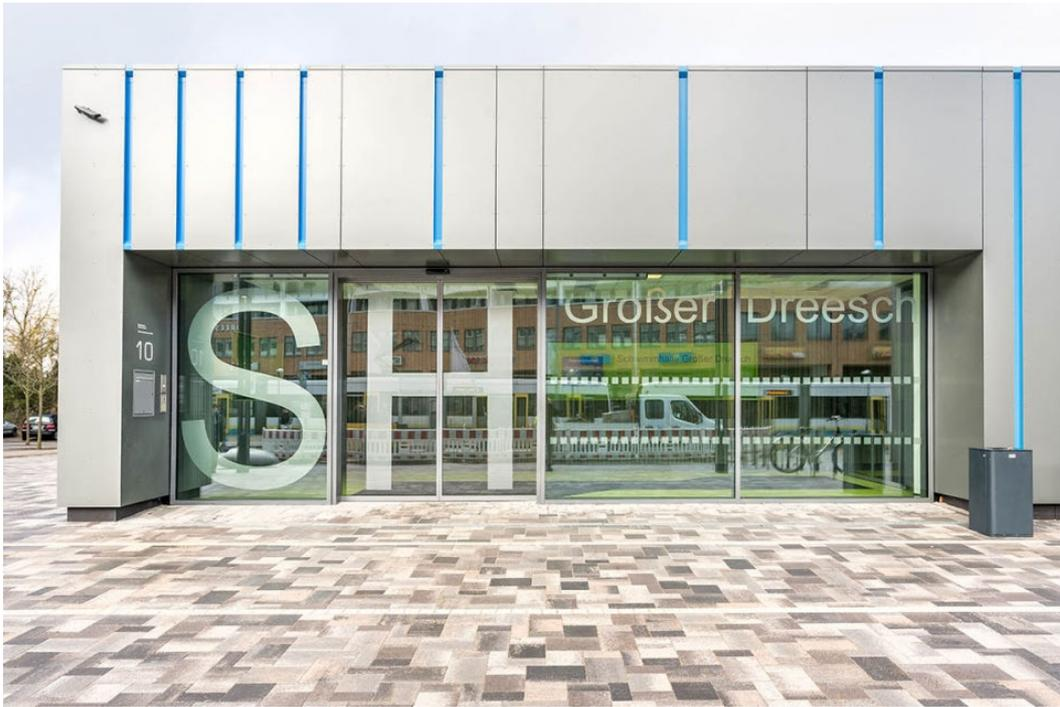
**ANGENEHMES FARBSPEKTRUM.** Die zurückhaltende Farbgestaltung der Fassade, ein dunkles Anthrazit, unterstützt die Form des Baukörpers. Diese wird durch umlaufende, blaue Streifen unterbrochen.
